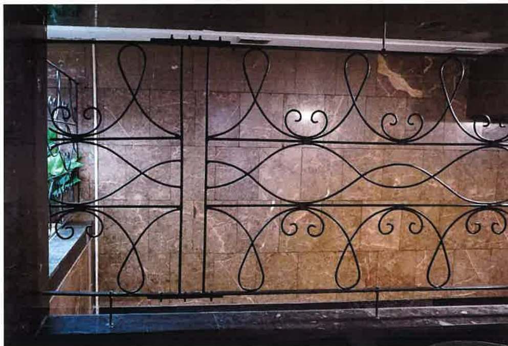
II. 82 Krata zabezpieczająca na antresoli
