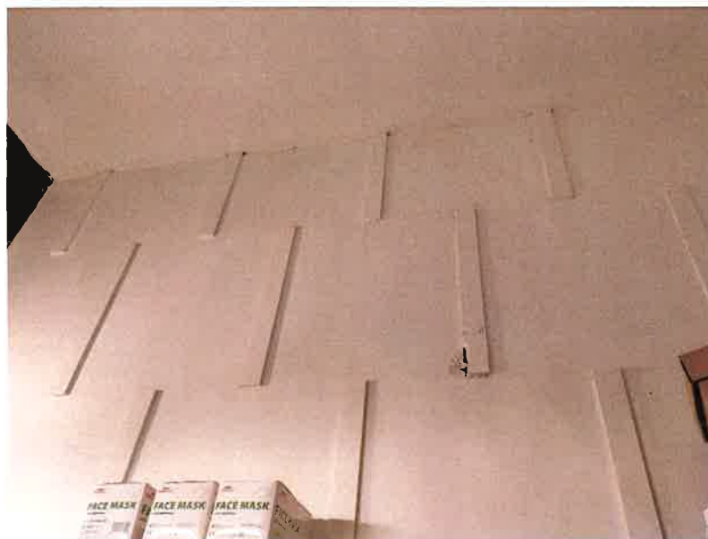
Il. 86, 87 Przykłady zamalowania okładziny kamiennej farbą (parter, zaplecze przy części sklepowej, antresola pomieszczenie techniczne od strony podwórka (ob. magazyn))
