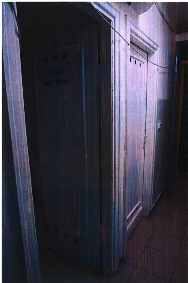
II. 70 Oryginalna stolarka w pomieszczeniach technicznych w piwnicy
