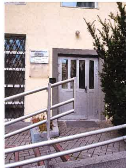
II. 134 Wejście na klatkę schodową nr I
