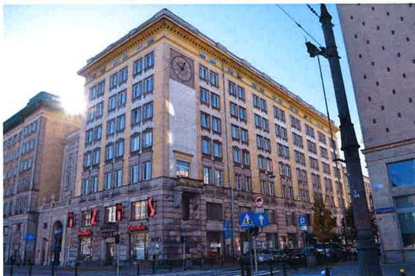
II. 118 Elewacja frontowa, narożnik, widok od ul. Marszałkowskiej
