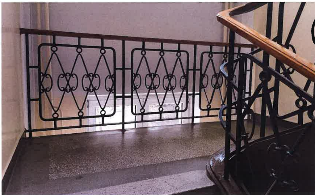
II. 150 Podest z balustradą na II klatce schodowej
