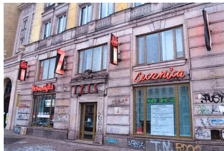
II. 121 Elewacja frontowa, wejście do lokalu użytkowego
