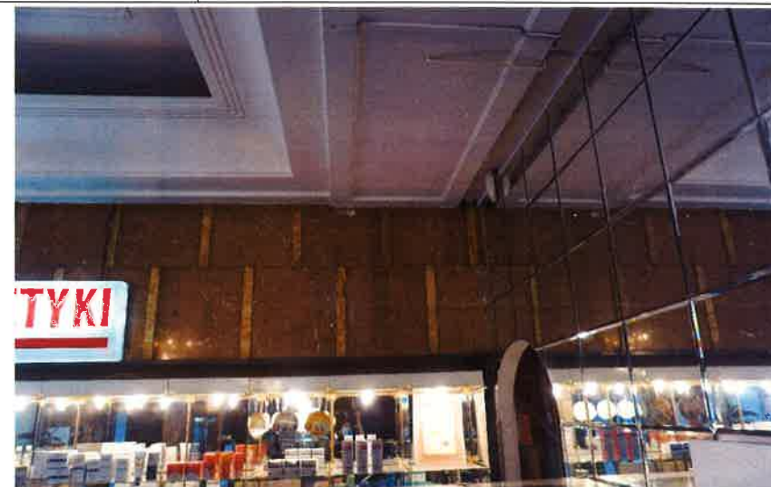
II. 45 Południowa część holu (sklepowa), kamienna okładzina, fragment sztukaterii na stropie i wtórna ścianka ze lustrzanymi panelami
