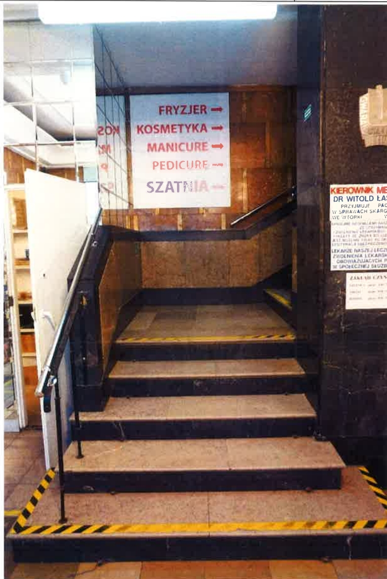
II. 55 Klatka schodowa, pierwszy bieg i podest, po lewej wtórna zabudowa
