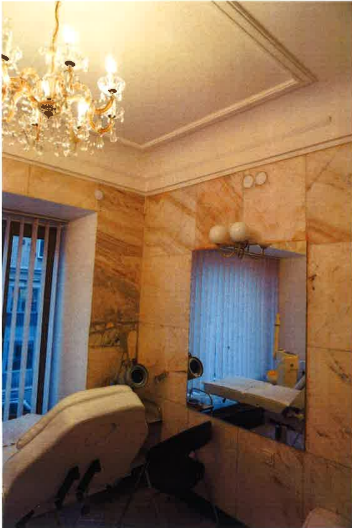
II. 61 Antresola, gabinet kosmetyczny (od ul. Marszałkowskiej) z zachowaną sztukaterią i kamienną okładziną ścian
