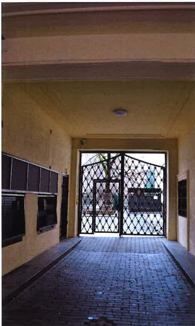
Il. 126 Przejazd bramny, widok na bramę od strony ul. Wilczej
