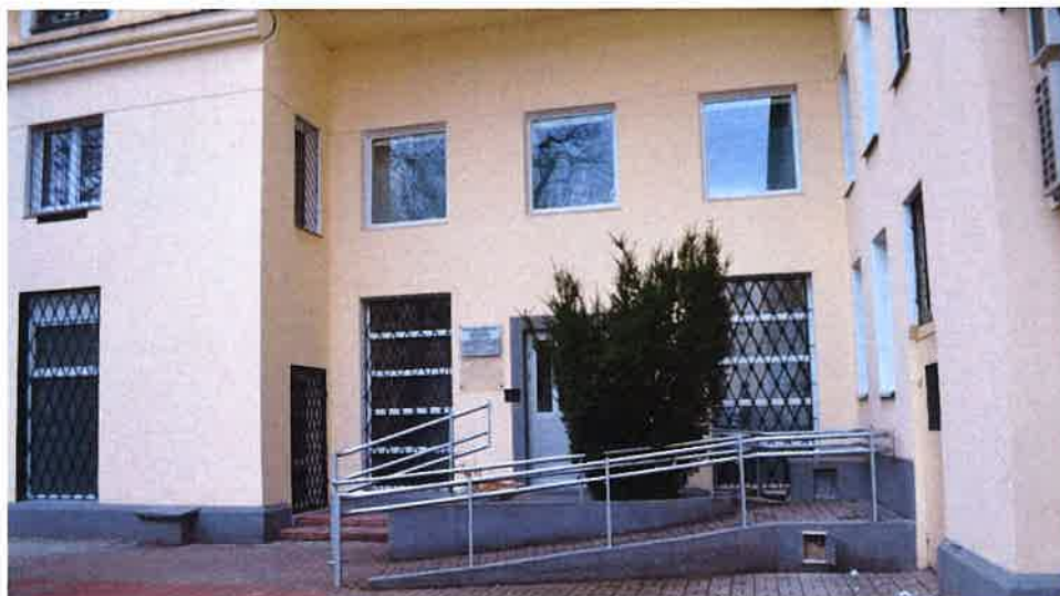
II. 133 Elewacja od podwórka, strefa wejścia
