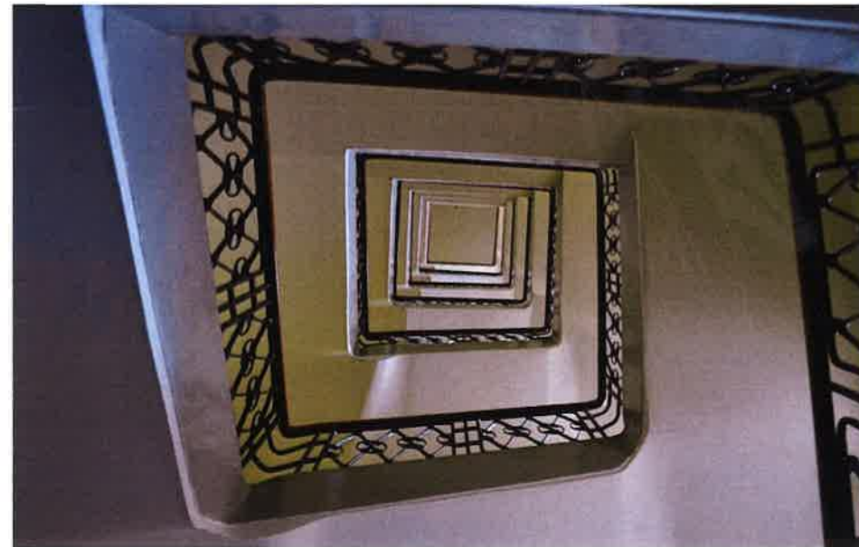
Il. 144 Dusza schodów na I klatce schodowej
