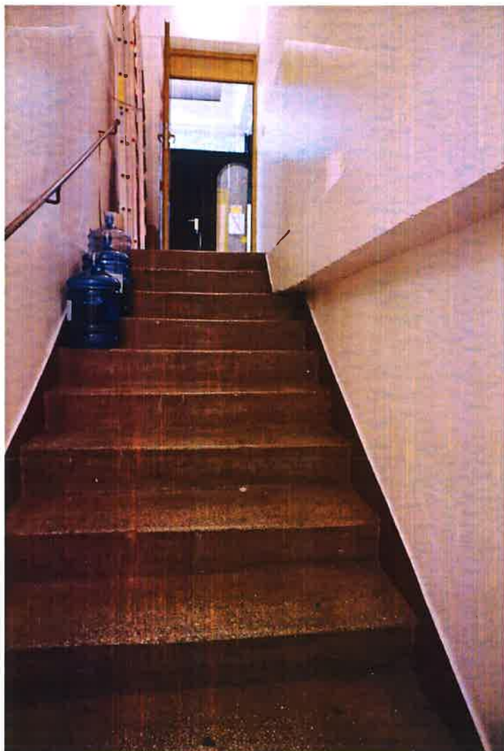
II. 69 Schody do piwnicy, widok na drzwi wejściowe z holu
