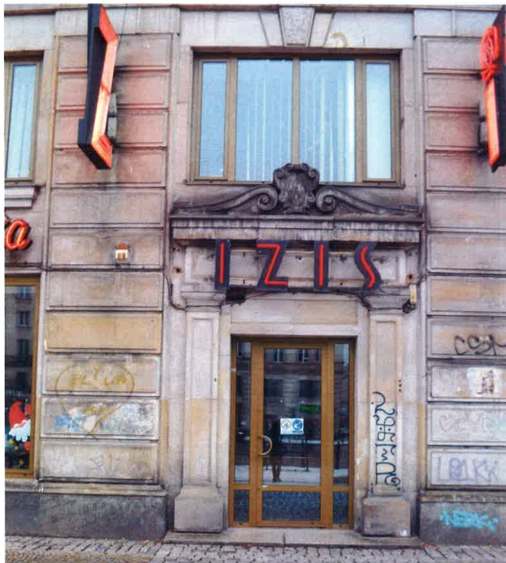
II. 30 Elewacja frontowa, wejście główne Kosmetyczno-Lekarska Spółdzielnia Pracy „Izisz”
