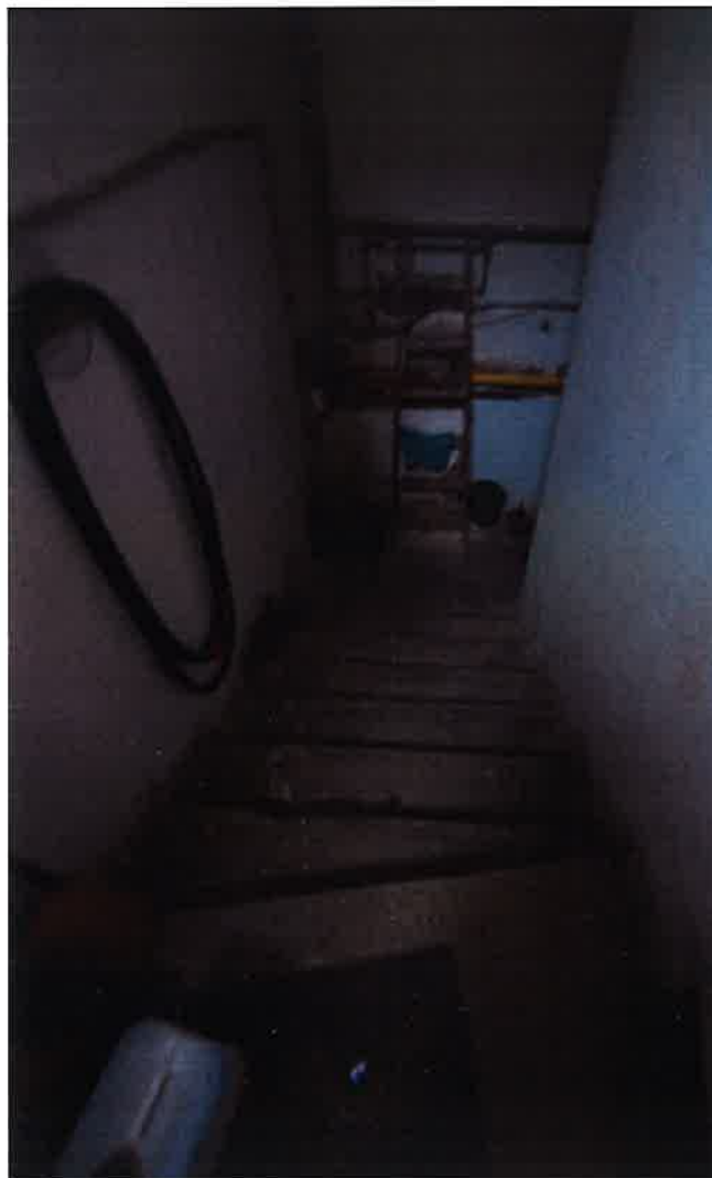
II. 153 Schody piwnicy na I klatce schodowej
