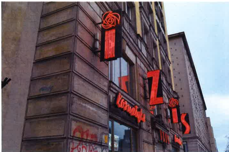
II. 33 Neon na elewacji - semafony
