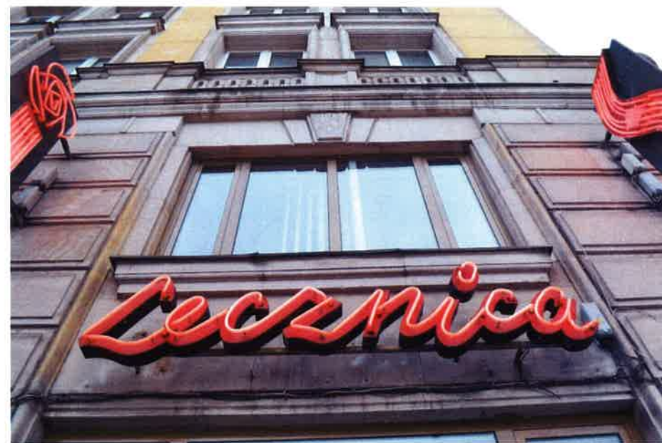
II. 36 Neon nad północną witrą elewacji frontowej
