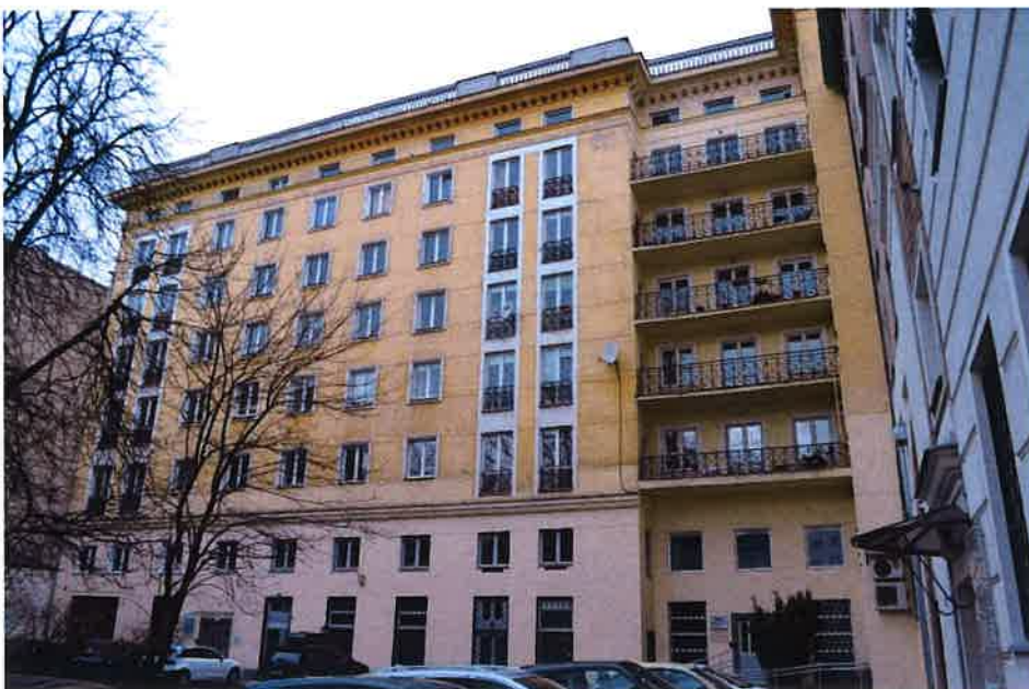
II. 129 Elewacja południowa od strony podwórka
