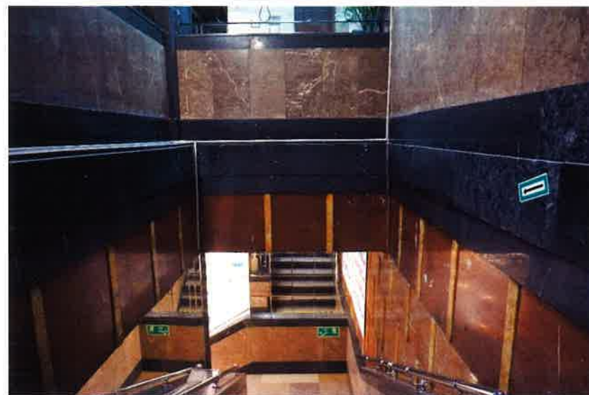
II. 56 Klatka schodowa z różnymi typami kamiennej okładziny, na kamiennych poręczach zamontowane wtórne pochwyty
