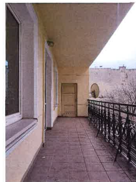
II. 137, 138 Balkon, widok na drzwi i okna na balkonie
