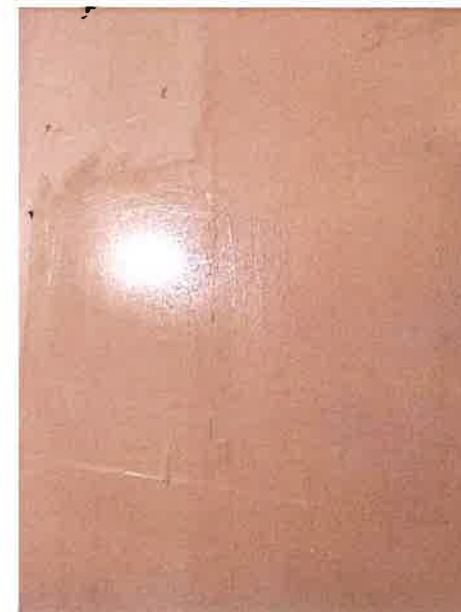
Il. 86, 87 Przykłady zamalowania okładziny kamiennej farbą (parter, zaplecze przy części sklepowej, antresola pomieszczenie techniczne od strony podwórka (ob. magazyn))
