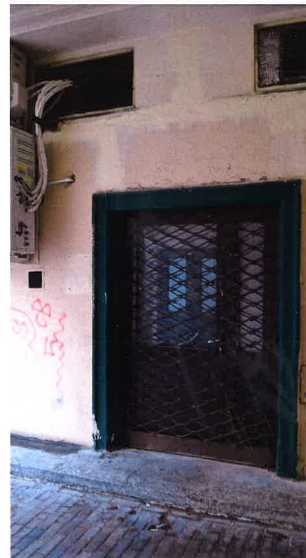
Il. 128 Przejazd bramny, wtórne drzwi (d. bar kawowy)
