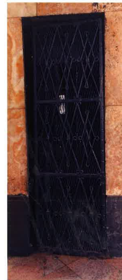
II. 39 Metalowa osłona grzejnika
