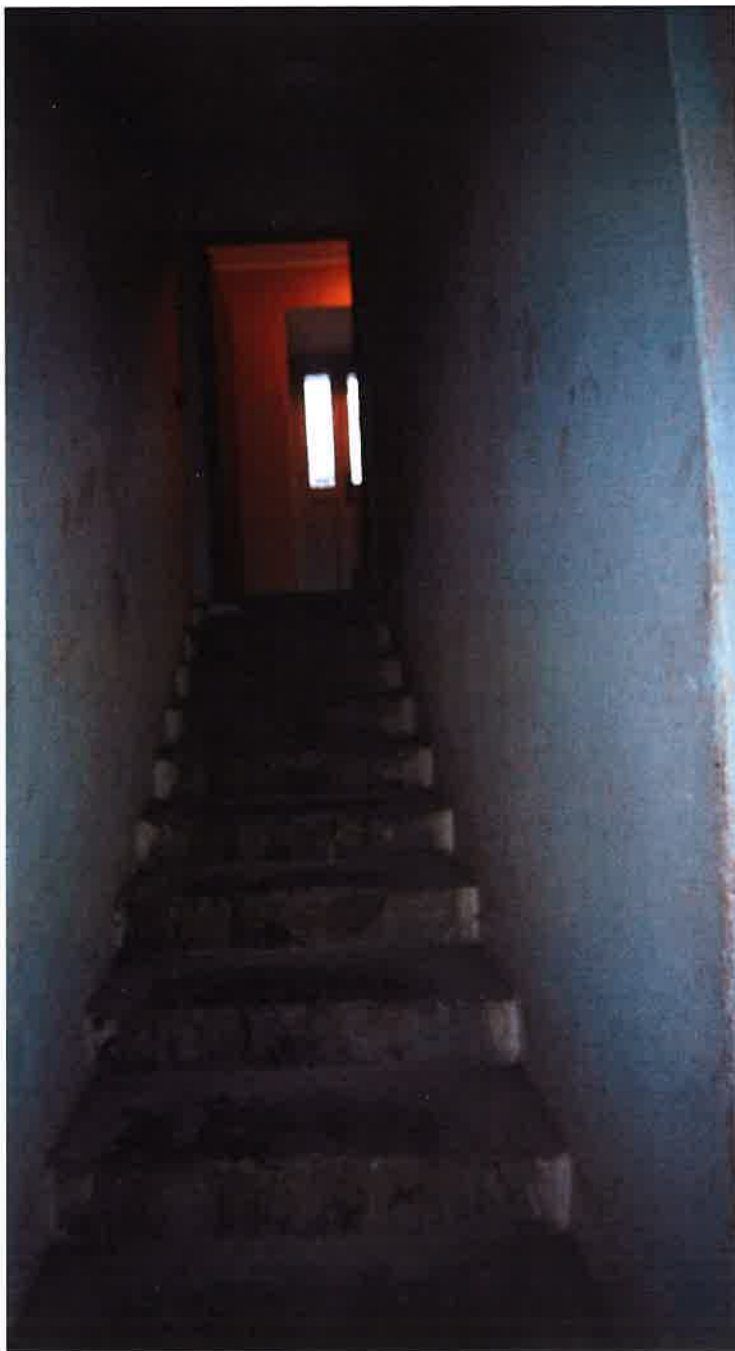
II. 155 Schody do piwnicy na II klatce schodowej
