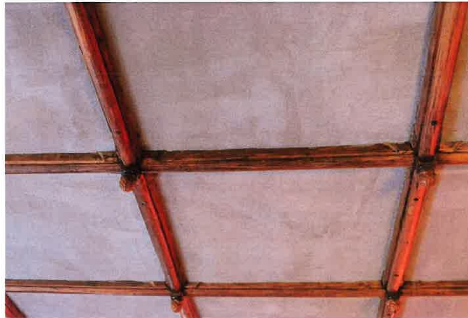
II. 103 Strop kasetonowy na piętrze – detal z dekoracyjnym zwornikiem
