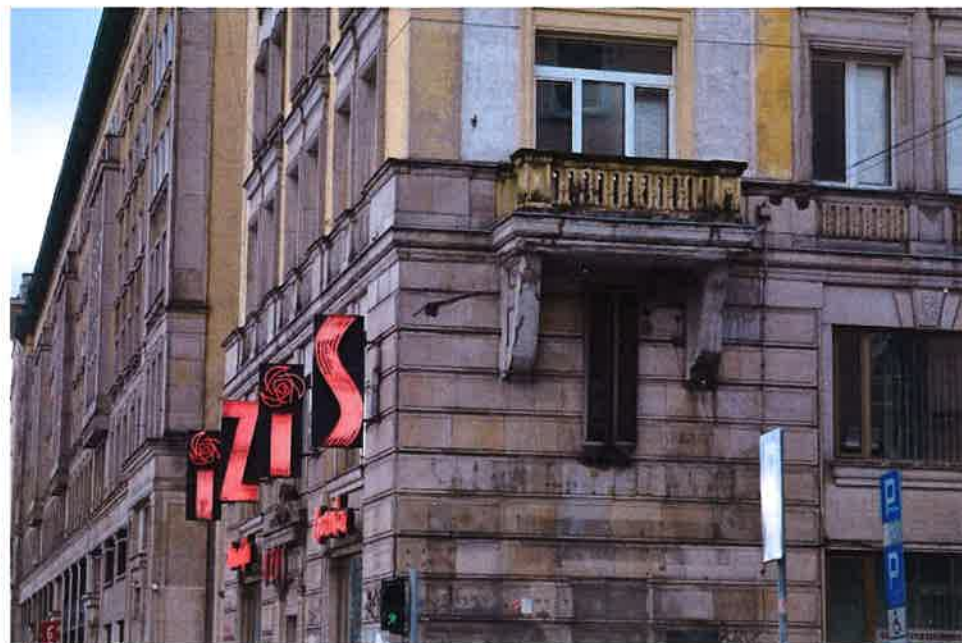
Il. 123 Elewacja frontowa, neon i balkon
