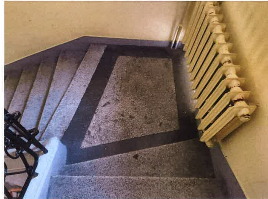
Il. 141 Podest schodów na I klatce schodowej
