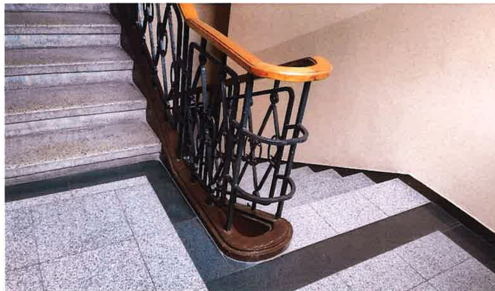
II. 149 Posadzka z marmuru i schody z lastriko na II klatce schodowej
