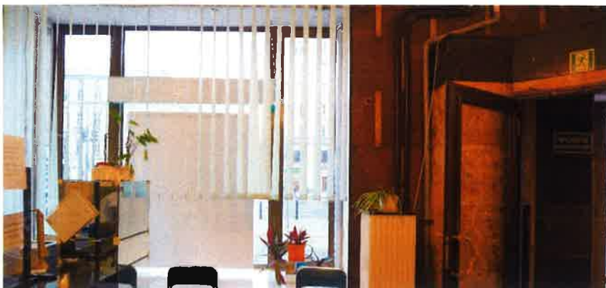
II. 44 Fragment przedsionka i witryna okienna w elewacji frontowej, obok wejścia grzejnik i prowadzona natynkowo instalacja
