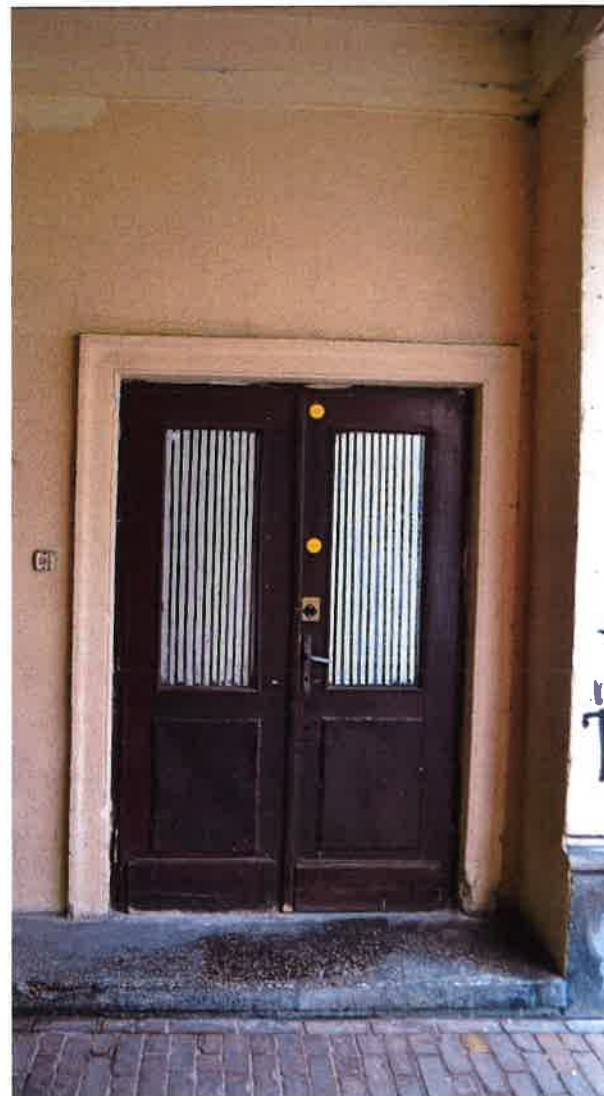
Il. 127 Przejazd bramny, oryginalna stolarka
