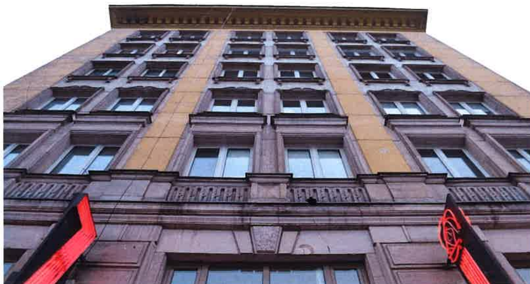
II. 120 Elewacja frontowa, widok elewacji powyżej antresoli, detal elewacji i gzyms
