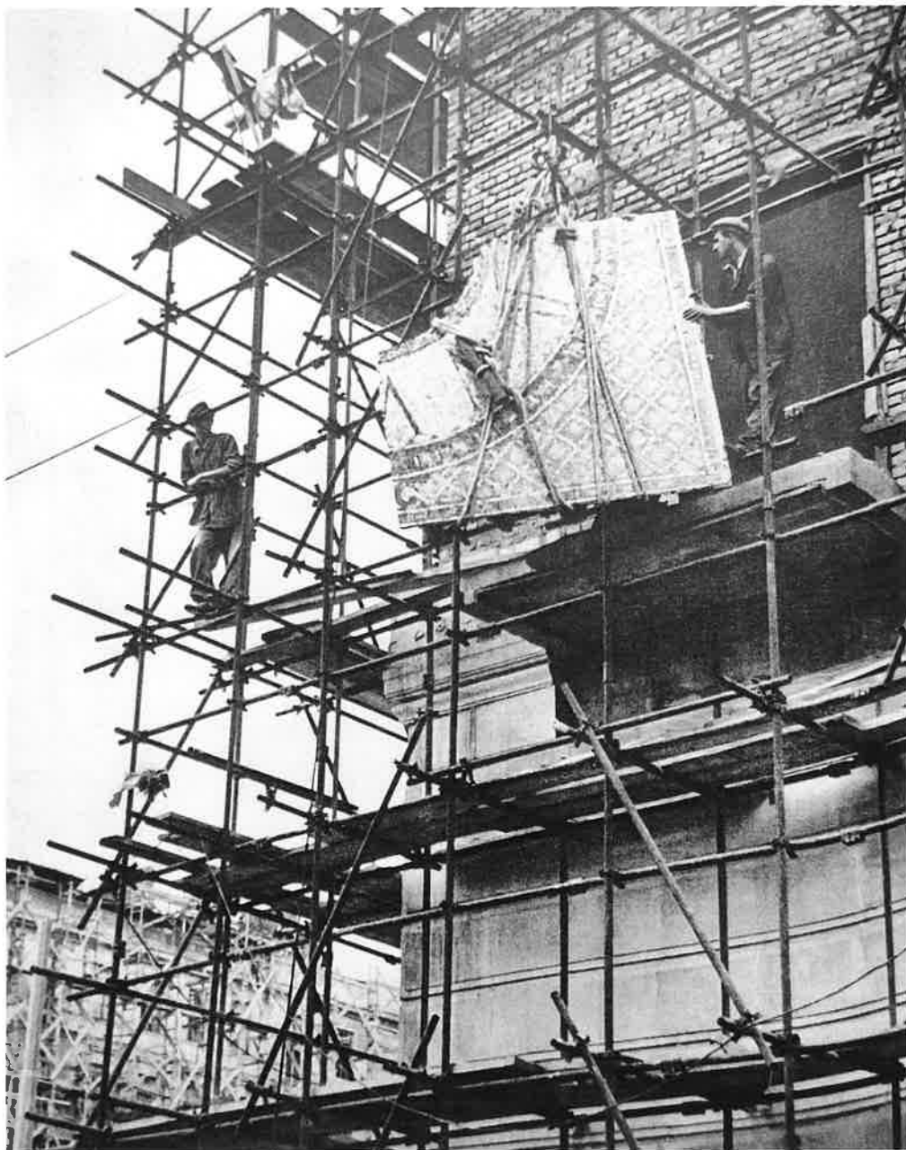
II. 105 Montaż tarczy zegara na elewacji budynku, fot. 1952, A. Nowosielski, CAF, repr. za MDM: Marszałkowska, 1730-1954
