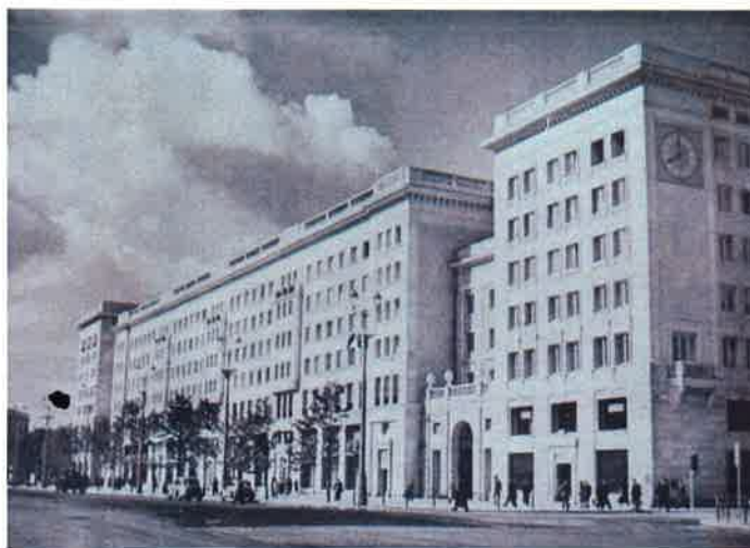
Il. 2 Budynek 1B i 1A od strony ul. Marszałkowskiej, fot. J. Bułhak, repr. „Architektura”, 1953, nr 1
