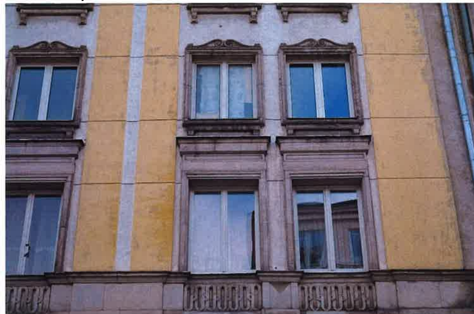
Il. 125 Elewacja frontowa, kamienna oprawa otworów okiennych i portfenetrów, detal
