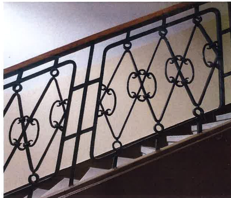
II. 151 Balustrada schodów na II klatce schodowej
