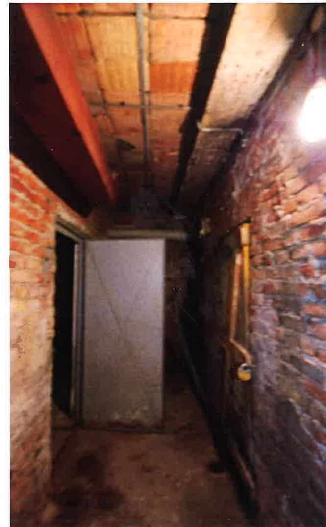
II. 154 Piwnica korytarz z widokiem na komórki lokatorskie
