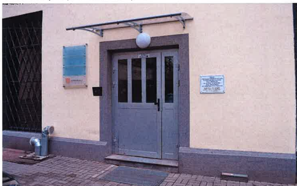
II. 136 Wejście na klatkę schodową nr II
