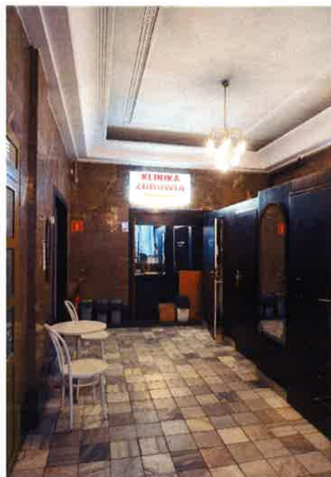
II. 47 Północna część holu, widok na dawne wejście gabinetu fryzjerskiego (ob. przesłonięte)
