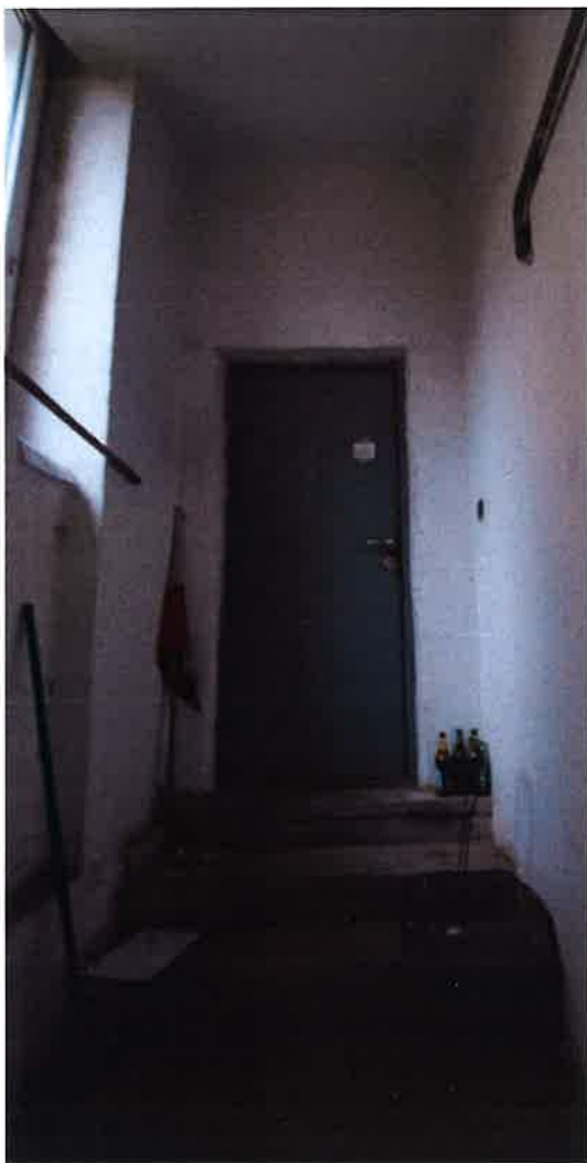
II. 152 Wejście do piwnicy I klatki schodowej
