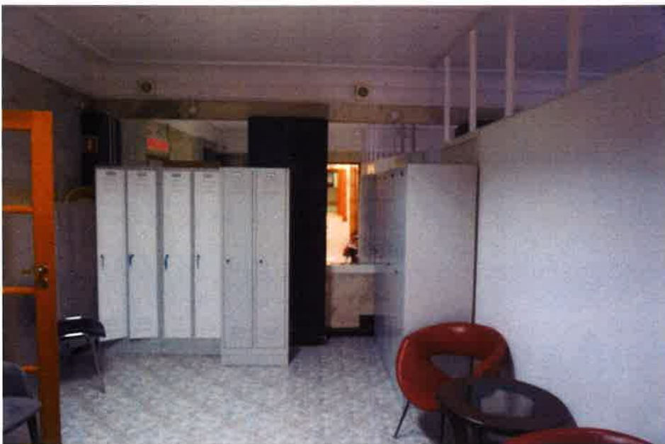
II. 64 Korytarz w zachodniej części na antresoli z wtórną ścianką działową i oryginalną kamienną okładziną
